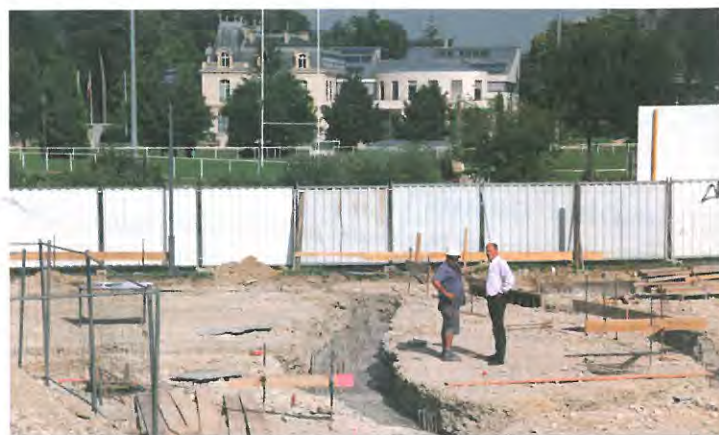
Sur le chantier du "Patio"
